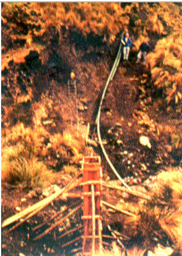
Reconstrucción de sistemas de abastecimiento de agua potable dañados por el terremoto de Cotopaxi - Ecuador. Marzo 1996
