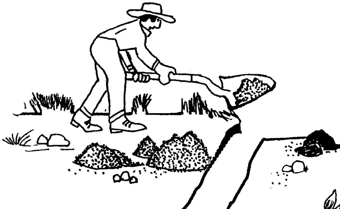
Excavar una zanja de 10 metros de largo por 30 a 40 centímetros de ancho y 90 centímetros de profundidad. A medida que se va utilizando, se va cubriendo con tierra (como el gato), el lugar debe estar cubierto con plástico u otro material, para proteger la intimidad de los usuarios (caseta provisional). Al terminar su vida útil se excavará otra zanja paralela con las mismas dimensiones de la anterior, en función del número de personas que la utilicen.
